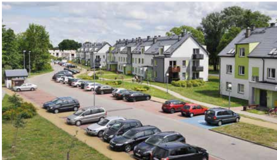
Osiedle mieszkań komunalnych przy ul. Kolejowej w Stepnicy
